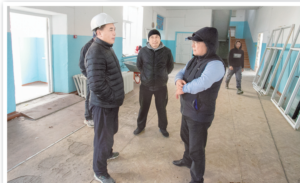
Капремонт лицея в Приютном начался с демонтажа старых конструкций
